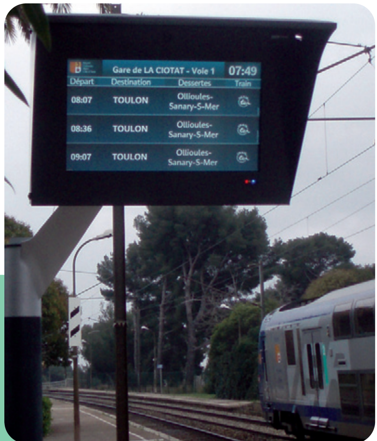
Depuis mars, 80 gares de la région offrent une information en temps réel sur la circulation des trains. Ces écrans sont pilotés à distance via le réseau GPRS.
